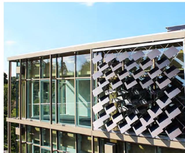
Le système est équipé d'une unité robotique en auto-apprentissage afin d'optimiser l'orientation du panneau tout au long de la journée et aussi de s'adapter aux changements de saison. Les prototypes génèrent des données de test afin que nous puissions déterminer leur production d'énergie et leur efficacité par rapport à d'autres systèmes.
