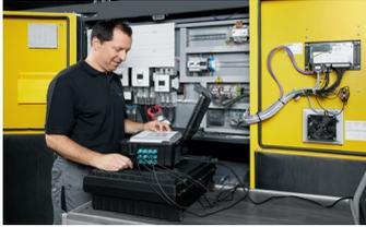
Surveiller la consommation d'air comprimé sur plusieurs jours (incluant les temps d'arrêt et les weekends) permet d'établir un profil de consommation fiable. Cela permet de définir la quantité d'air comprimé à différentes périodes de production en incluant les fluctuations (consommation standard ou pic de consommation). Les économies potentielles sont alors identifiées dans un rapport.
